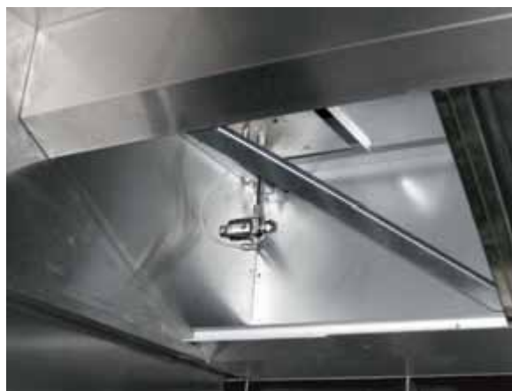
Détail d'un injecteur dans une hotte
